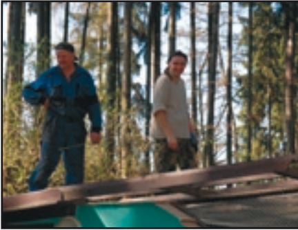
Údržba při opravě střechy u papoušků Repairing of the roof of parrot house
