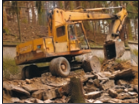
Zahájení prací na opravě cesty Starting of repairing the road
