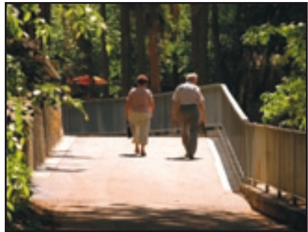
Cesta po dokončení The road after finishing
