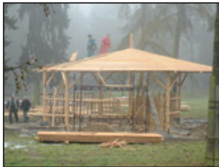
Stavba nových přístřešků v safari výběhu Construction of new shelters in the Safari enclosure
