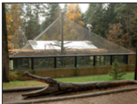
Jihoamerický pavilon po dokončení oprav střechy South-American Pavilion after the completed roof repairs
