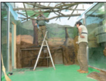
Dokončování vnitřních úprav v Jihoamerickém pavilonu Finishing the interior of the South-American Pavillion
