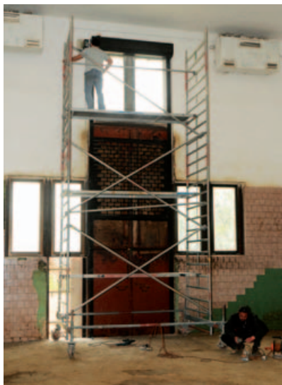
Montáž elektrického zavírání dveří v pavilonu žiraf /Mounting of electrical door closing in the giraffe pavilion/
