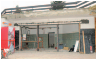
Oprava restaurace Pod Věží /Reconstruction of the restaurant Pod Věží/
