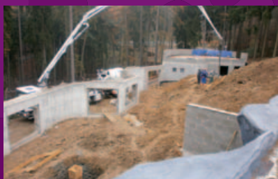
Stavba výběhů pro levharty mandžuské /Construction of enclosures for Amur Leopards/
