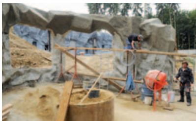
Umělé skály ve výběžích pro levharty vyrábí naši pracovníci /Artificial rocks at enclosures for Leopards are made by our workers/
