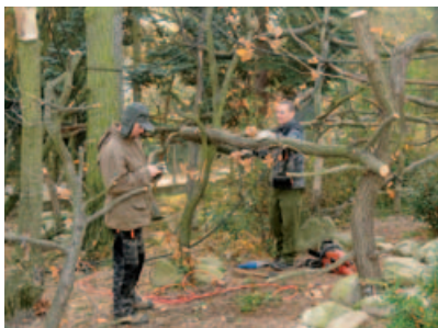
Výstavba a doplnění parkosů ve výběhu nosálů červených /Construction and adding of crubs in the enclosure of Coaties/
