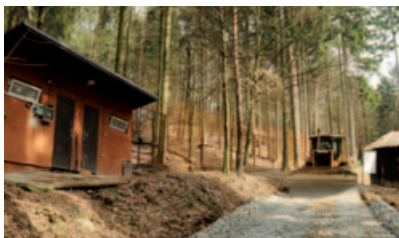
Oprava cesty pod výběhy vlků a jelenů /Repair of the road below enclosures of wolves and deers/
