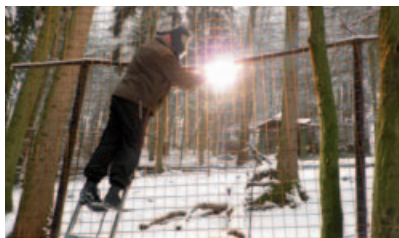
Opravy oplocení výběhů vlků /Repairs of fencing of wolves' range/
