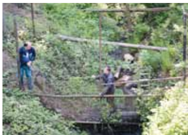
Oprava oplocení ve výběhu makaků /Reconstruction of macaques enclosure/
