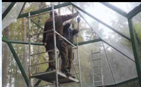
Opravy venkovních výběhů pavilonu opic /The maintenance work on the pavilion of monkeys/
