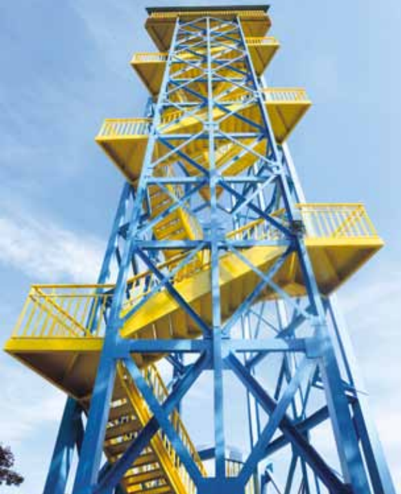
Vyhlídková věž dostala nové antikorozní nátěry /The observation tower got new anticorrosive coating/
