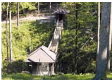
Pohled na opravený výběh makaků /The view of the repaired enclosure of macaques/
