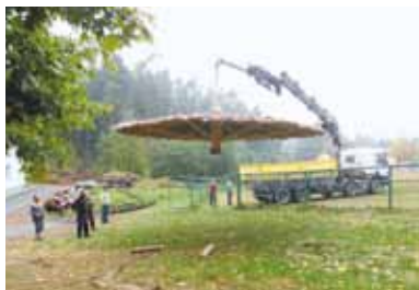
Osazení stříšky ve výběhu žiraf /The installation of the roof in the enclosure/
