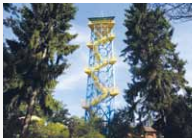
Vyhlídková věž v novém kabátě přímo září /The observation tower in a new shining coat/
