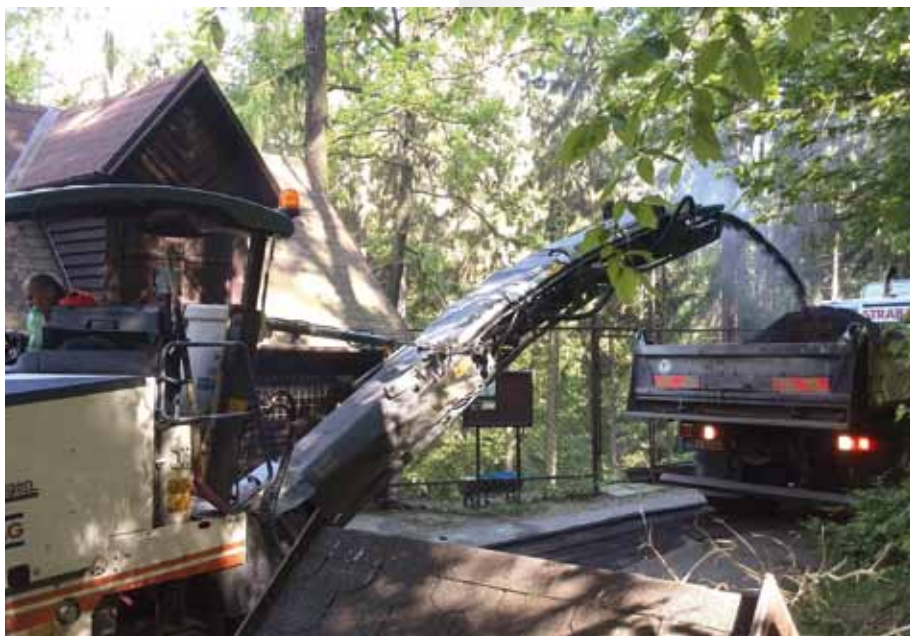
Opravy zvlněných živých vozovek v areálu zoo /The maintenance work on the wavy bituminous roads in the zoo/
