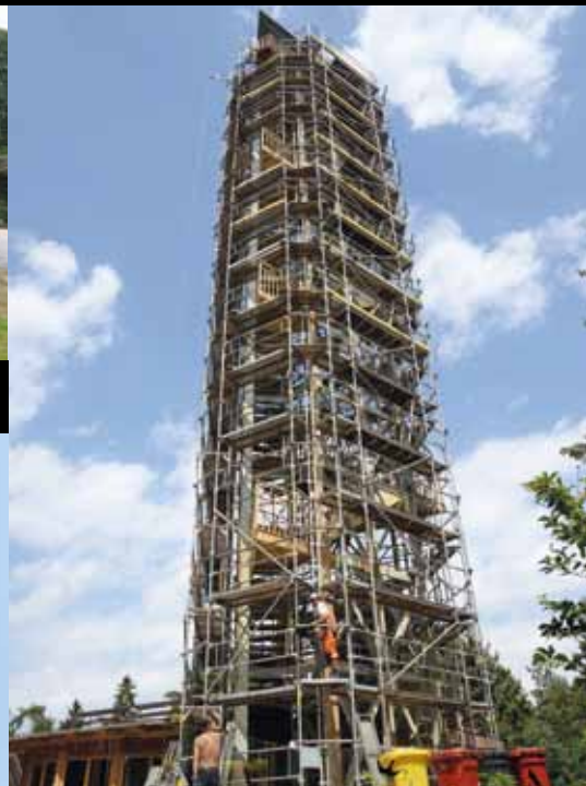
Vyhlídková věž s lešením /The observation tower with scaffolding/
