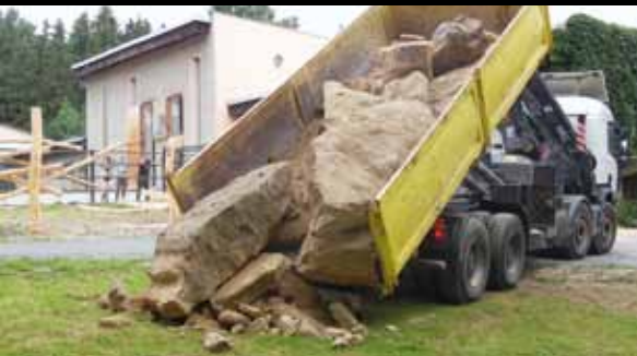
Navážení kamenů na stavbu výběhu žiraf /The delivery of stones for giraffes enclosure/
