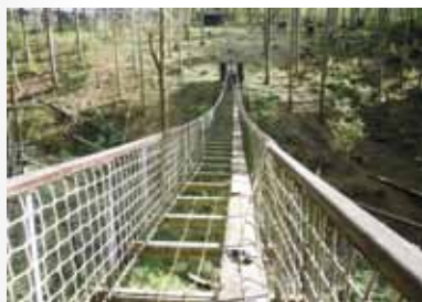
Oprava lávky ve výběhu makaků /The maintenance work on the footbridge/
