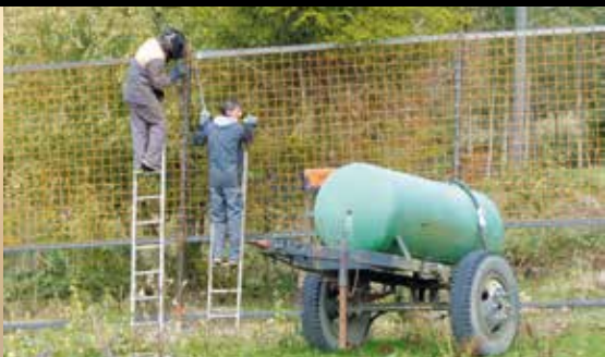
Oprava oplocení ve výběhu pakoňů /Repairing of fence in Wildebeest enclosure/
