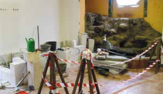
Stavbu terárií jsme zahájili v únoru /Terrarium construction started in February/
