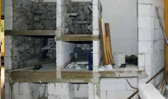
Kostru terárií tvoří tvárnice /Construction is from Ytong blocks/
