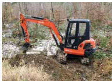
Výkopy provádí externí firma /External company performed excavation work/
