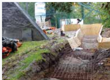
Výstavba potůčku ve voliére /Small stream will be in aviary/
