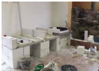
Kostru terárií tvoří tvárnice Ytong /Construction is from Ytong blocks/
