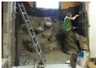
Výroba umělých skal /Making of artificial rocks/
