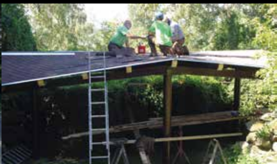
Stavba přístřešku u pískoňů /Building of shelter for Muskox/
