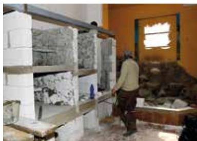
Hrubá stavba nových terárií /Rough construction of new terrariums/
