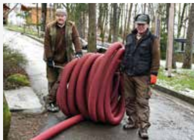
Příprava na pokládku kabelu /Preparation for electric cable laying/
