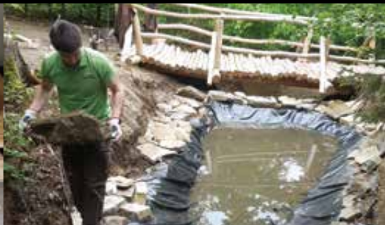
Výstavba tůň /The construction of water pools/
