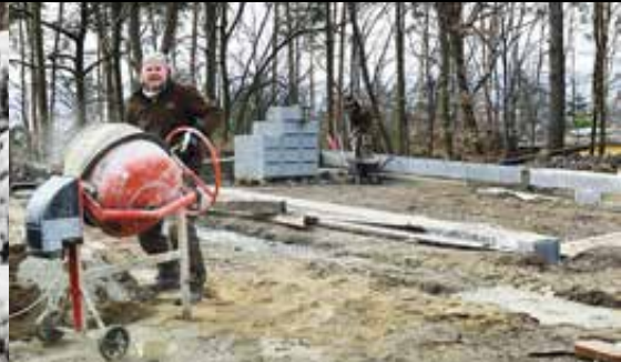
Na jaře jsme zahájili stavbu gastru /We started the construction of a restaurant/
