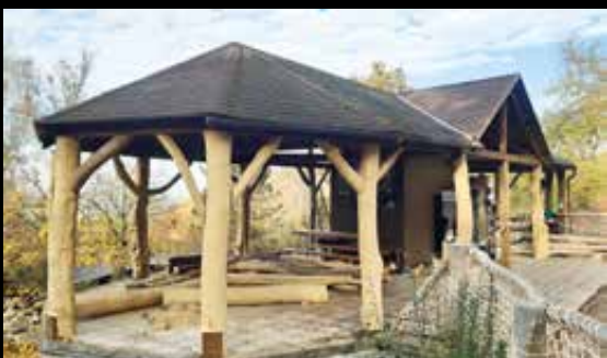
Oprava vyhlídky na výběh pižmoňů /The reconstruction of the lookout for the Muskox/
