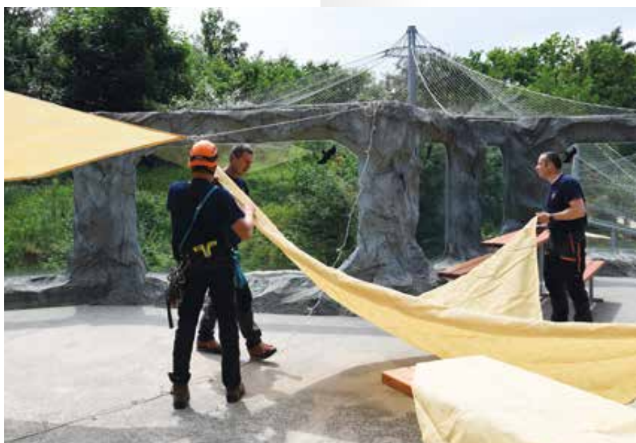
Instalace stínících plachet /Installation of the canvas blinds/
