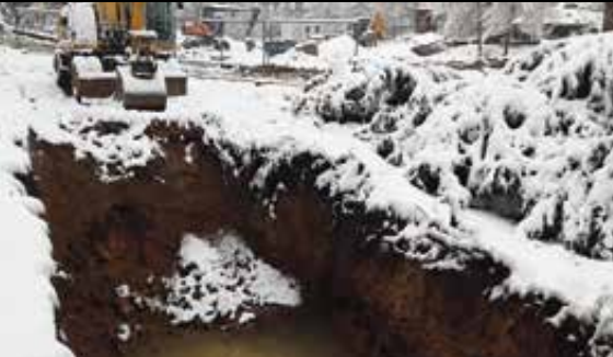
Hloubení jámy na další nádrž /Digging a hole for another retention basin/
