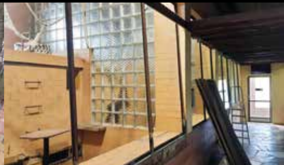
Výměna skel v pavilonu opic /The replacement of the window panes/
