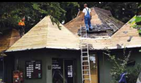
Oprava střechy na Pavilonu netopýrů /The roof reconstruction of the Bat House/
