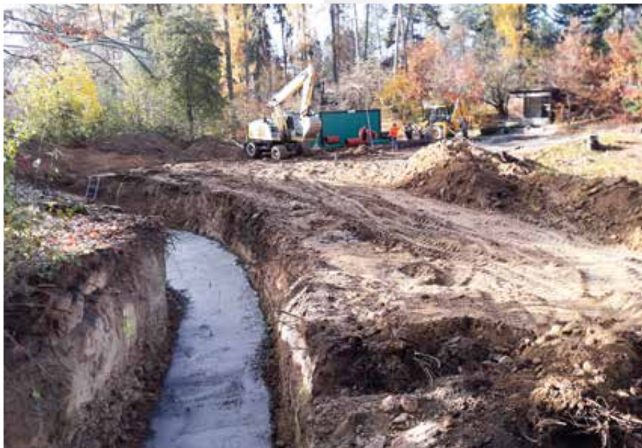
Akce „Hospodaření s dešťovou vodou“ /The event „Management with the rainwater“/
